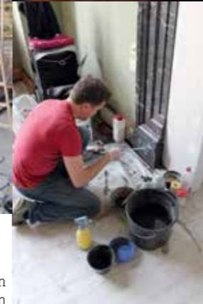
Stuckateur beim Ausbessern beschädigter Stellen
