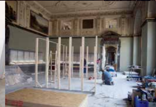
Die Holzkonstruktion ist der Unterbau für das Hallstatt-Geländemodell.
